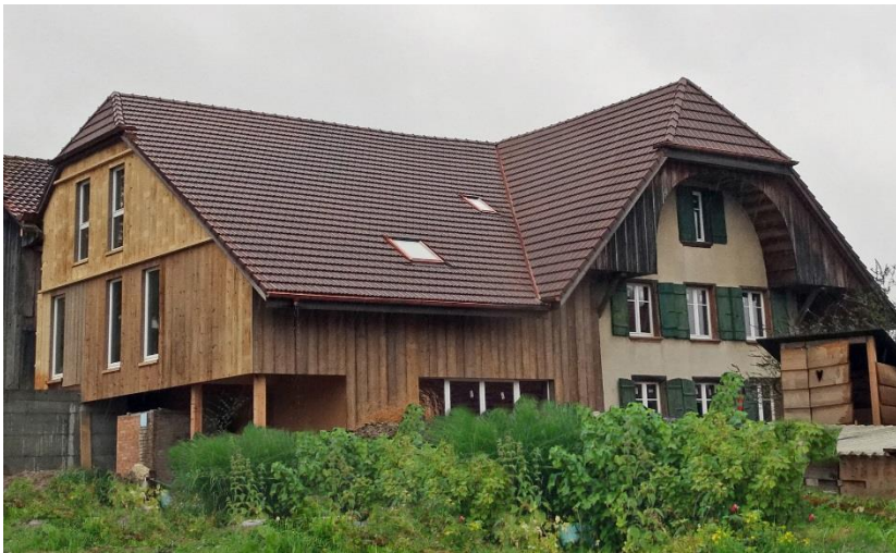
Hausansicht HSA Nord-West im Bau
